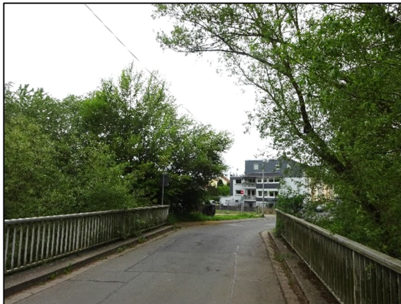
Abb. 10: Brücke im Bereich Unterwirtstraße (eigene Aufnahme 05/2026).
